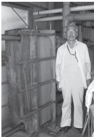
写真1-a 排水からの熱回収用のチタンプレート式熱交換器
