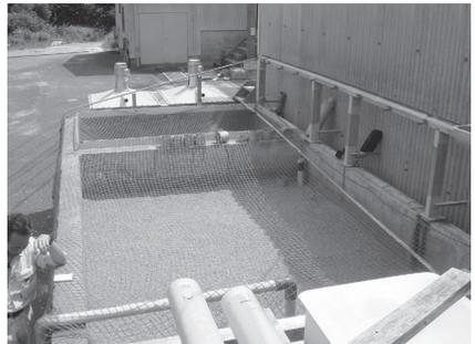
**写真5-d カキ殻と砂を濾材とした濾過槽**
