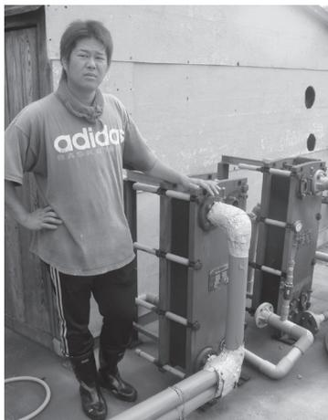
熱交換器を2台導入し(2台とも同型)、1台目で地下水からの熱回収を、2台目で温水ボイラーによる追加加温を行っている(写真2-a)。すなわち、地下水からの熱で13℃から15℃に加温された新水は、2台目のプレート式熱交換器で17℃に加温され、稚魚の水槽に供給される。後者の熱源は温水ボイラー(20万kcal/時)で、別途この系統用の送水ポンプを設置している。
