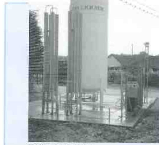
液体酸素タンクと酸化機。
