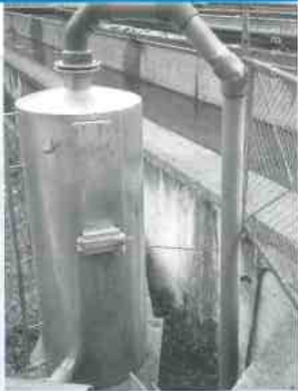
加圧式の酸素溶解器。
