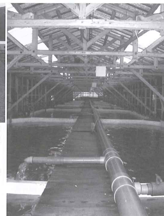
掛け流し式陸上養殖場の一例。木造建屋内にコンクリート水槽が設置されている。本稿の写真は何れも、西日本トラフグ陸上養殖協議会提供。
